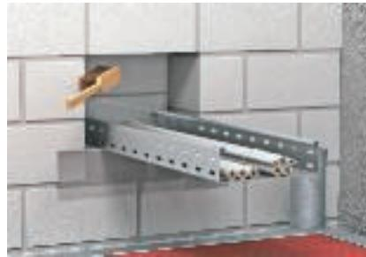
Очистить отверстие и закрепить вспомогательную оснастку опалубки, например, клейкую ленту
